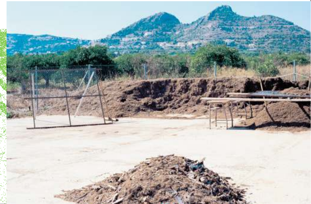
PLANTA DE COMPOSTAJE DE DENIA (ALICANTE)_I.E.L.
